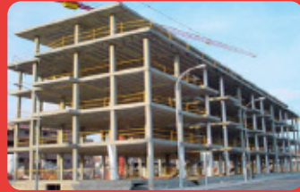
Estructura de Hormigon
